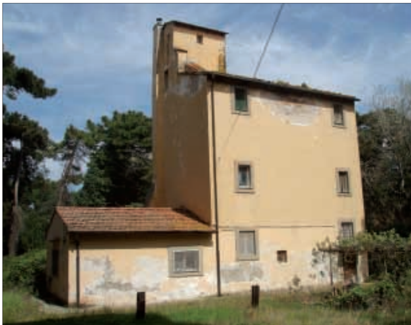
Fortino di mezza piaggia a tirrenia (2007).
